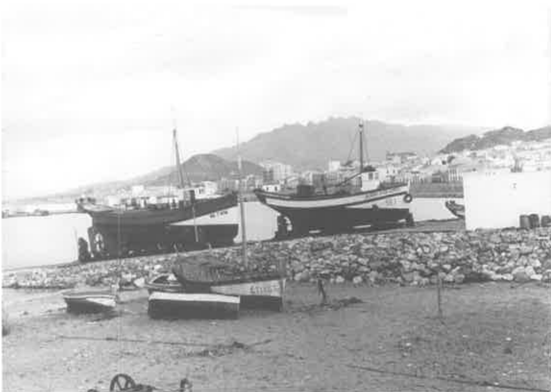
El varadero de Garrucha, recién construido.
