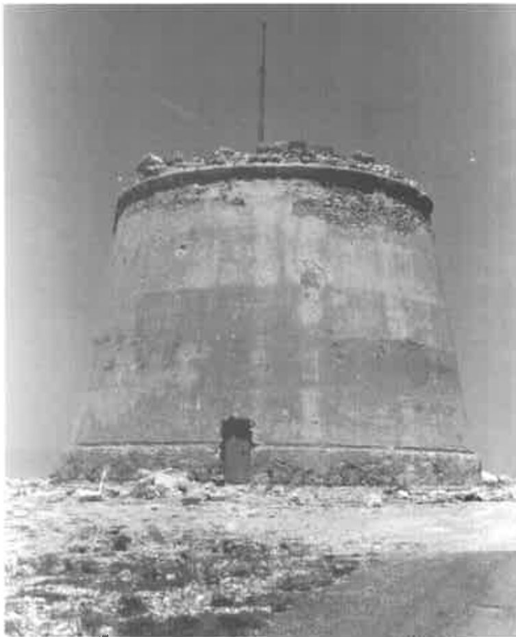
Torreón artillado de Mesa de Roldán (Carboneras) construido estando Pedro Badía como contador y tesorero de cuentas del partido de Vera.
